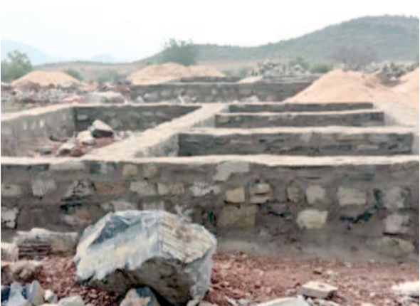
అన్నమయ్య ప్రాజెక్టు వరదబాధిత గ్రామం పులపత్తూరులో నిలిచిపోయిన పక్కా ఇళ్ల నిర్మాణం
